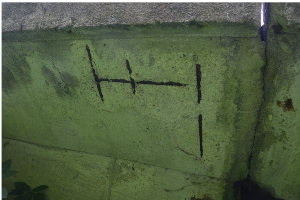
Obr.F62-55 Odtržená krycí vrstva betonářské výztuže u levého křídla nad čtvrtou opěrou, krnovskou opěrou, pohled zprava doleva ve směru staničení.
