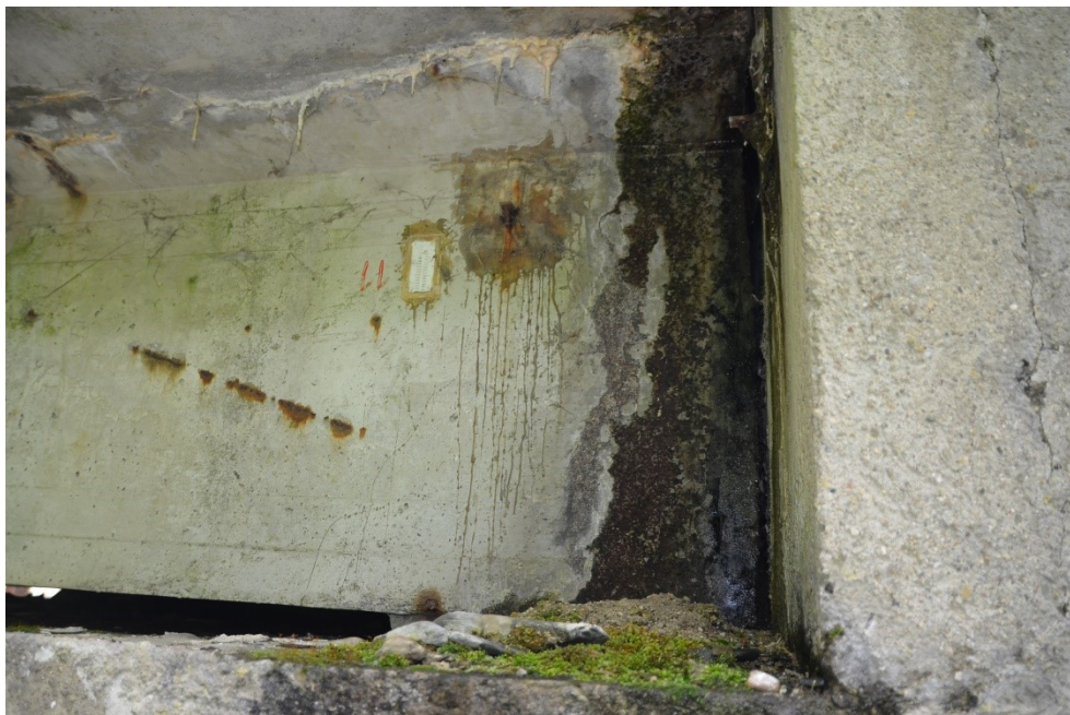
Obr.F62-05 Začátek levé, povodní fasády nosníku č.1 v uložení na první podpěře, olomoucké opěře. Pohled zprava doleva ve směru staničení,
