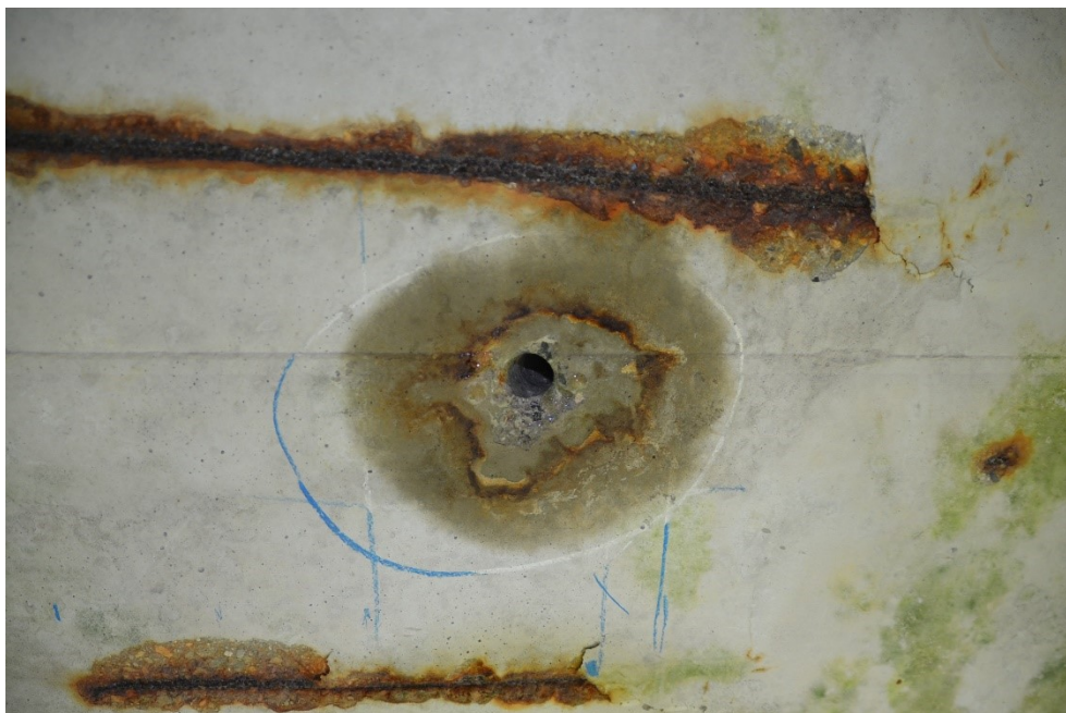
Obr.F62-49 Odvodňovací dutina v nosníku č.2 ve třetím poli u třetí podpěry, pohled ve směru staničení,
