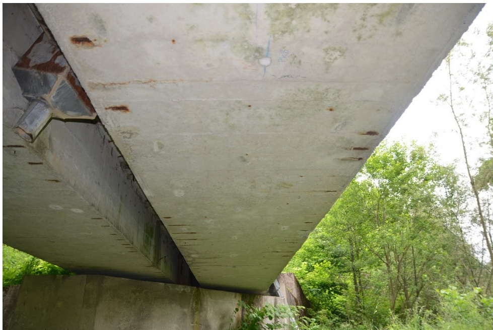
Obr.F62-43 Podhled nosníku č.2 a jeho uložení na čtvrté podpěře, krnovské opěře, pohled ve směru staničení a vzhůru,
