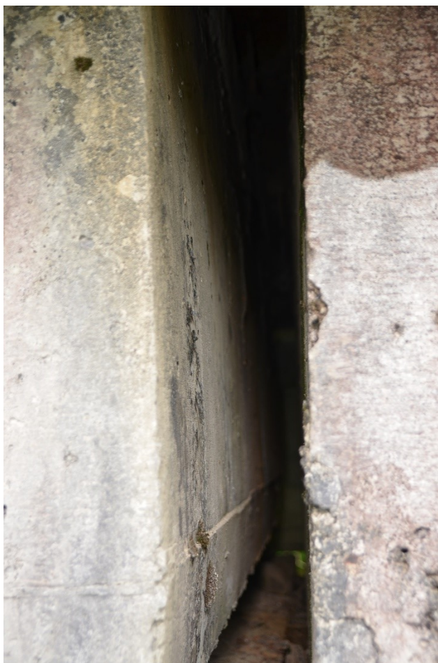
Obr.F62-56 Detail dobetonávky čela nosníku č.2 nad třetí podpěrou, pohled zleva doprava ve směru staničení.
