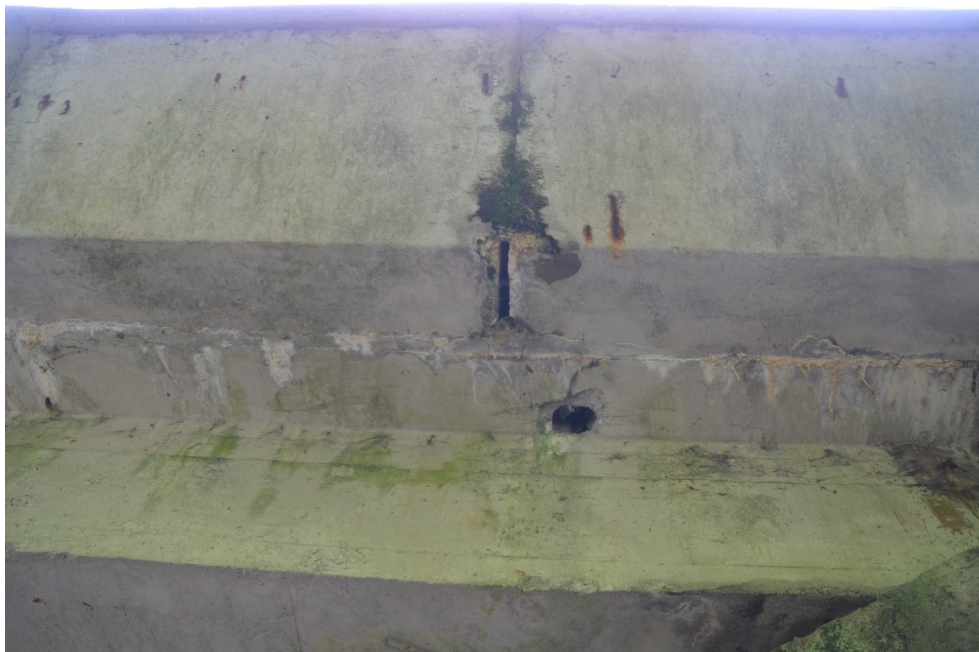
Obr.F62-47 Typický případ poruchy, styk římsových konzol a horních přírub nosníků, na obr. konkrétní případ ve druhém poli nad nosníkem č.1 první spára za druhou podpěrrou, pohled zprava doleva ve směru staničení, - viz obr. F62-45.
