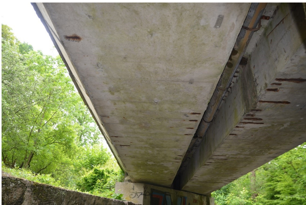
Obr.F62-34 Podhled nosníku č.2 a jeho uložení na první podpěře, olo-moucké opěře, pohled proti směru staničení a vzhůru,
