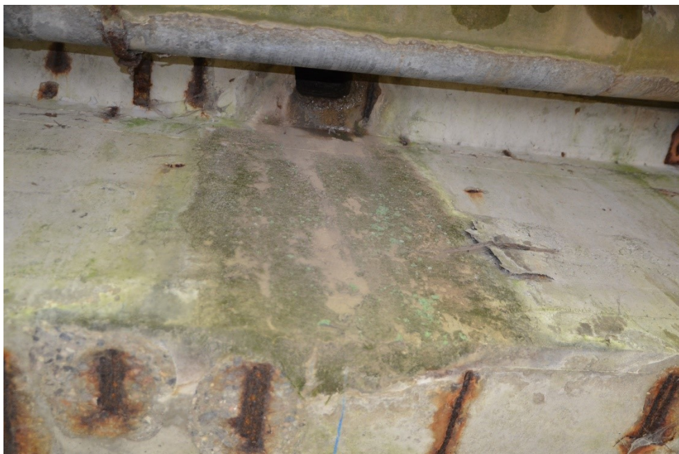
Obr.F62-54 Nezapravená montážní dutina v levé fasádě nosníku č.2 v prvním poli, pohled zleva doprava proti směru staničení,
