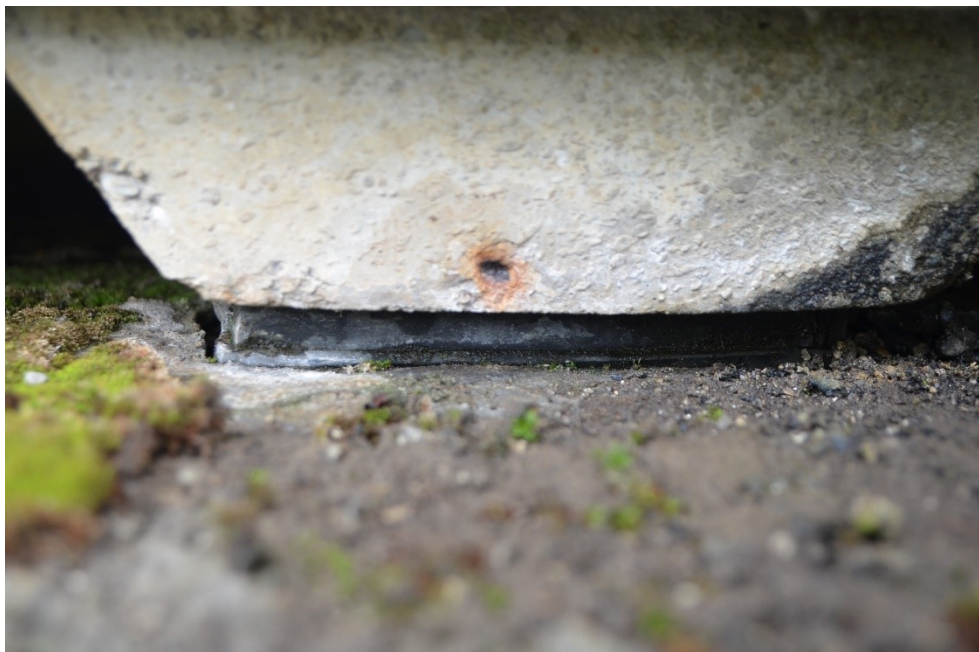
Obr.F62-44 Pohyblivá ložiska pod nosníkem č. 2 na čtvrté podpěře, krnovské opěře. Pohled zleva doprava ve směru staničení,
