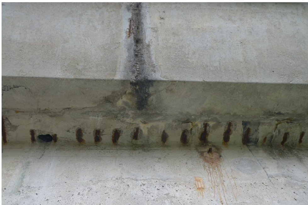
Obr.F62-48 Typický případ poruchy, styk římsových konzol a horních přírub nosníků, na obr. konkrétní případ na začátku třetího pole nad nosníkem č.2, pohled zleva doprava ve směru staničení, - viz obr. F62-45.
