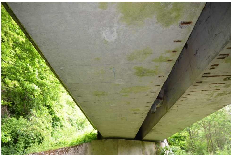
Obr.F62-41 Podhled nosníku č.1 a jeho uložení na čtvrté podpěře, krnovské opěře, pohled ve směru staničení a vzhůru,
