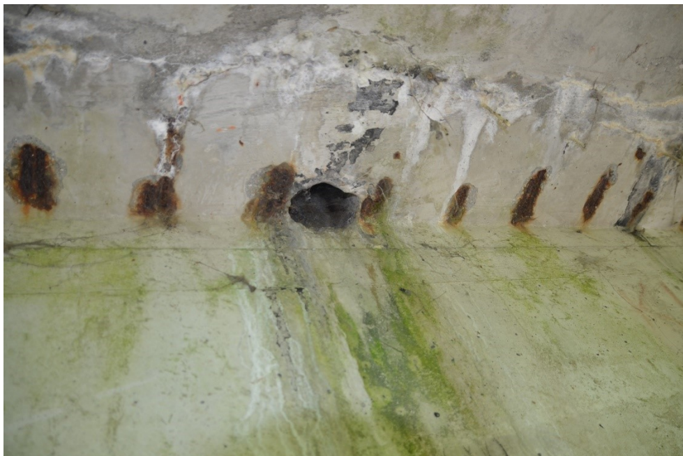
Obr.F62-53 Nezapravená montážní dutina v pravé fasádě nosníku č.1 v prvním poli, pohled zleva doprava ve směru staničení,
