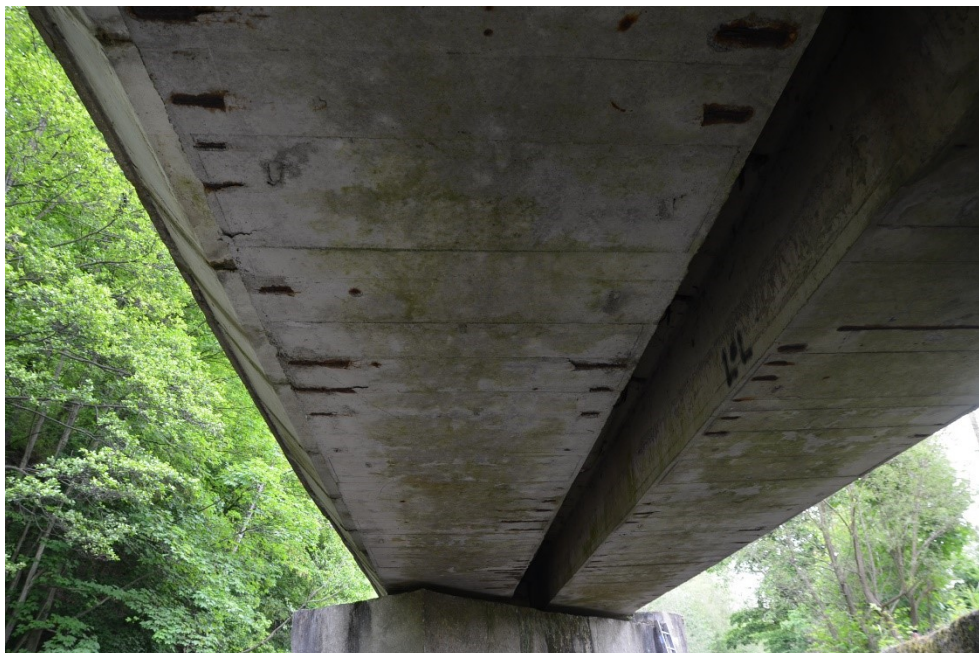
Obr.F62-33 Podhled nosníku č.1 a jeho uložení na druhé podpěře, pohled ve směru staničení a vzhůru,
