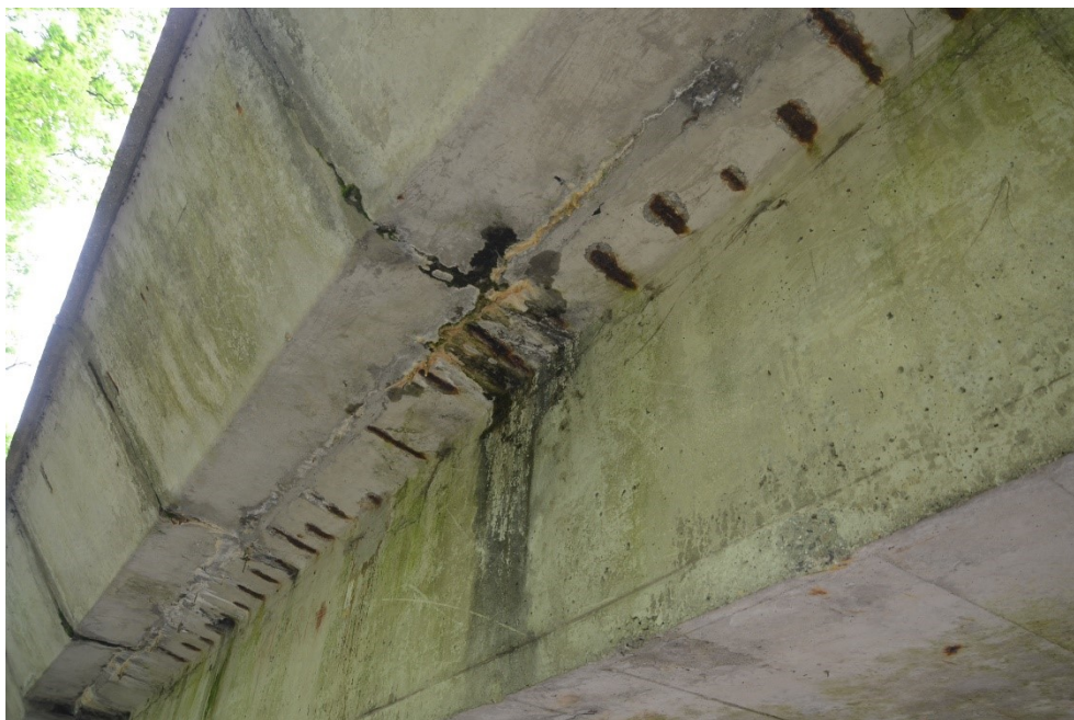
Obr.F62-45 Typický případ poruchy, styk římsových konzol a horních přírub nosníků, na obr. konkrétní případ v prvním poli nad nosníkem č.1 třetí spára před druhou podpěrrou, pohled zprava doleva ve směru staničení,
