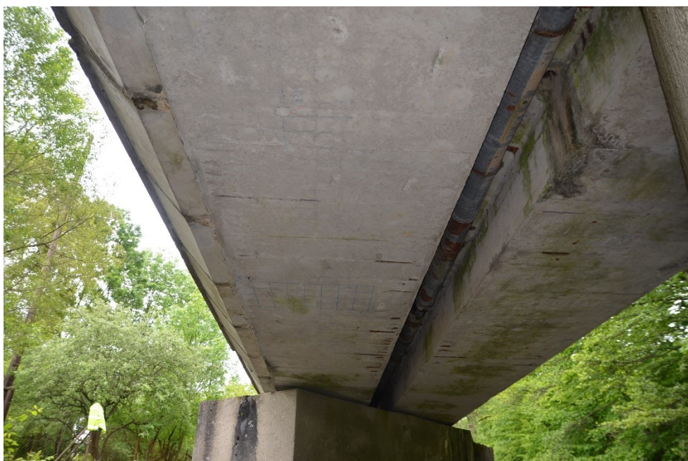
Obr.F62-38 Podhled nosníku č.2 a jeho uložení na druhé podpěře, pohled proti směru staničení a vzhůru,
